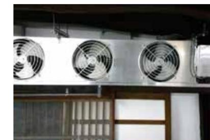
仕込み蔵全体を冷却するために導入した「中低温エアコン」
