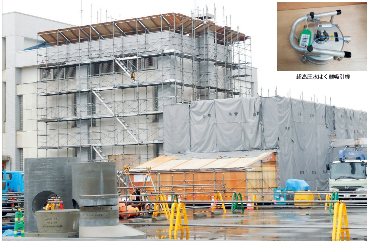
超高压剥離吸引除去工法による作業現場
