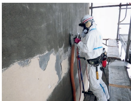
超高压剥離吸引除去
